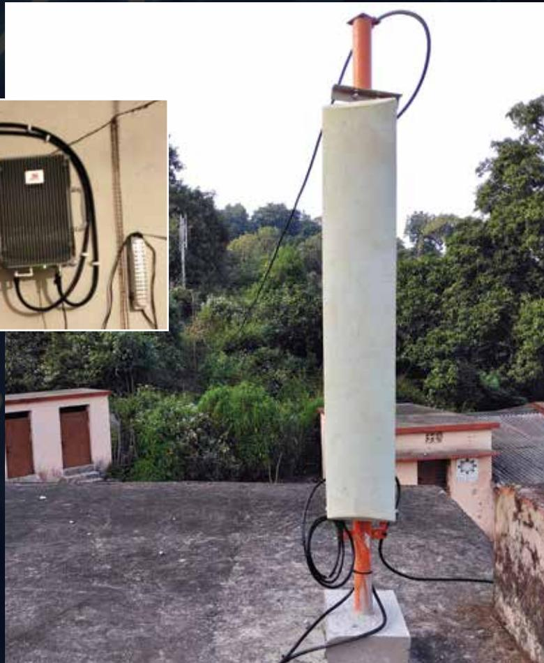
Antenne GSM à 2 ports fixée sur le poteau de 3 mètres du toit de l'école.
